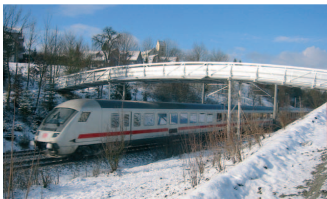
Bild 13. Aluminiumbrücke über die Eisenbahnstrecke bei Mühlheim (Quelle: pml)
